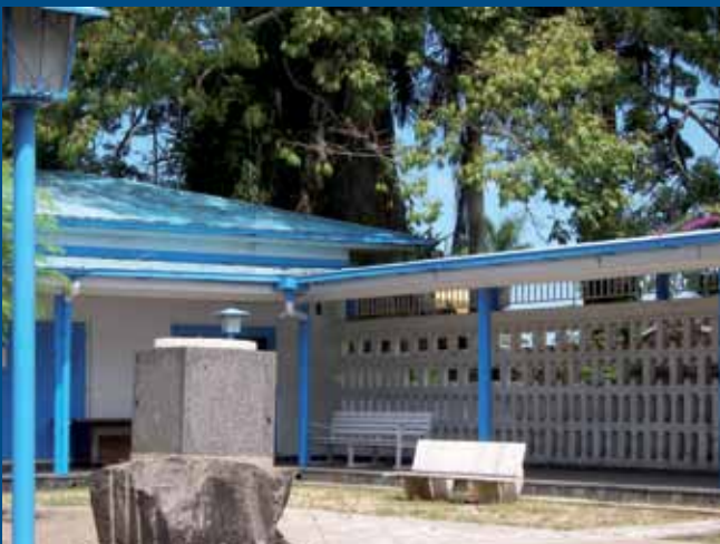
De binnentuin van het logegebouw op de hoek Kwattaweg en Van Idsingastraat in Paramaribo is ontworpen rond een kubieke steen die intussen lichtjes scheef staat.
